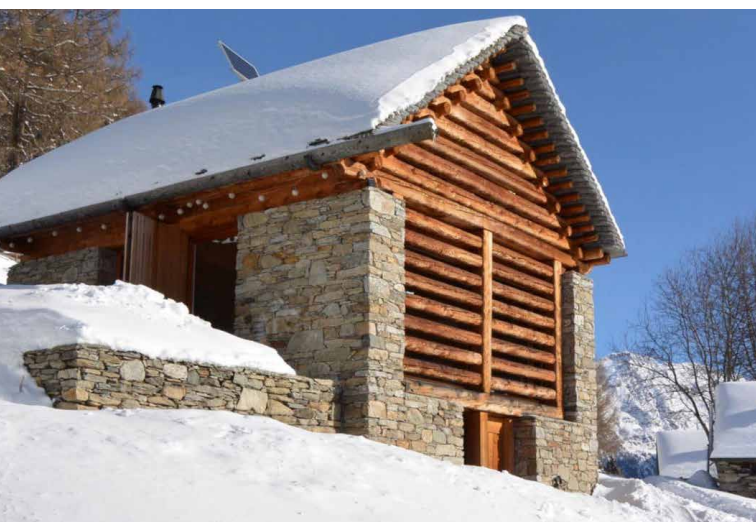
Das Rustico nach der Sanierung und Umnutzung zum Wohnhaus
