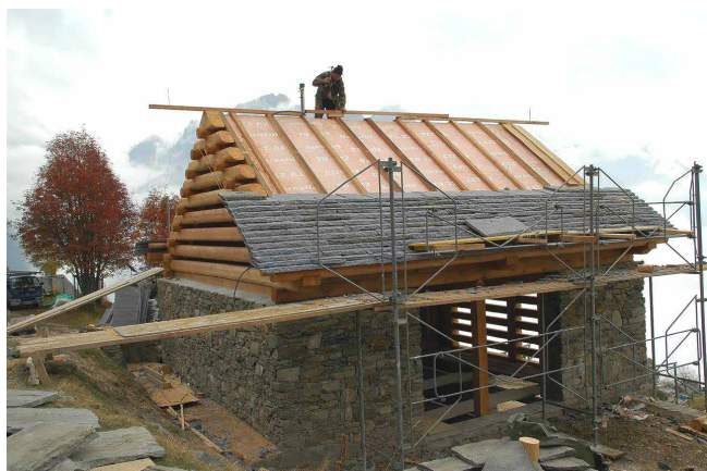
Bei der Erneuerung des Dachs wurde ein Teil der Steinplatten wiederverwendet
