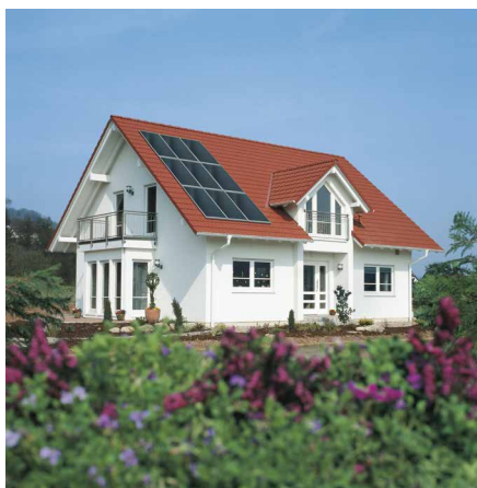
Einfamilienhaus mit Photovoltaikmodulen: Wer selbst Strom produziert spart teuren Netzstrom.
