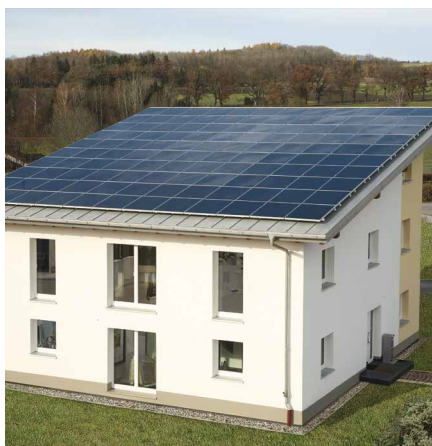
Mit einer Photovoltaikanlage auf dem Dach kann jeder Eigentümer Stromproduzent werden.
