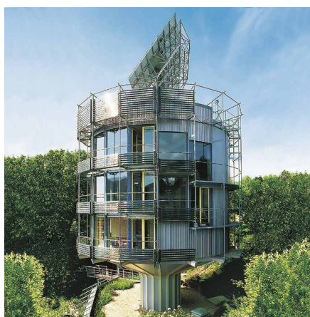
Das Heliotrop in Freiburg im Breisgau des Architekten Rolf Disch mit Vakuum-Röhrenkollektoren.
