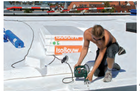
Dämmung mit Zusatznutzen: Bei Flachdächern kann das Dämmsystem auch gleichzeitig für das erforderliche Gefälle sorgen.
