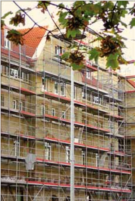
Baustelle im Bestand
